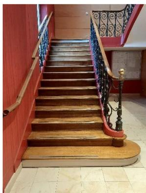
Dans la montée d'escaliers intérieurs de la mairie, une nouvelle rampe côté mur a été mise en place, similaire à la rampe existante.
