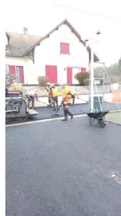
La rue de la Varenne d'en Haut a fait peau neuve. Un caniveau destiné à recueillir les eaux pluviales a été mis en place, et la chaussée a été recouverte d'un enrobé. Des aménagements paysagers seront mis en place prochainement.
