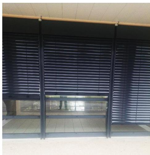
Des brise-soleil ont été installés à la salle des fêtes, côté sud-ouest, pour limiter l'impact de la chaleur au lieu et place d'une climatisation trop énergivore.
