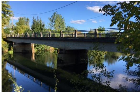
Suite à des vents violents en 2015 et quelques chutes d'arbres, devenu défectueux, le pont a été fermé et remis en état par la commune. Les piles et les arches étaient en bon état, des pierres et des garde-corps ont été remplacés.
