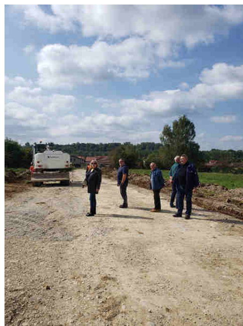
Réunion de chantier aux Chenevières
